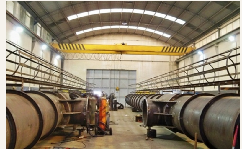
Interior y puente grúa
